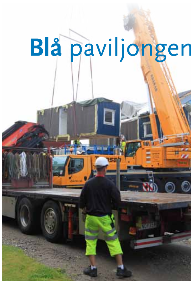
Ovan Alla 16 modulerna lyfts på plats från lastbilssläpet med hjälp av en stor kran.
